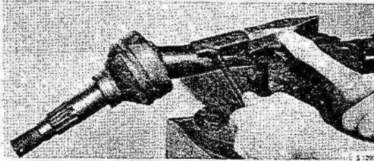
DEGAGEMENT DE MOYEU AVEC LE MANDRIN 784202
